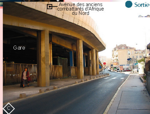
● Vue vers MARSEILLE côté voie 1
