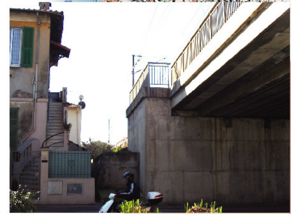
Vue du PRA côté voie 2
