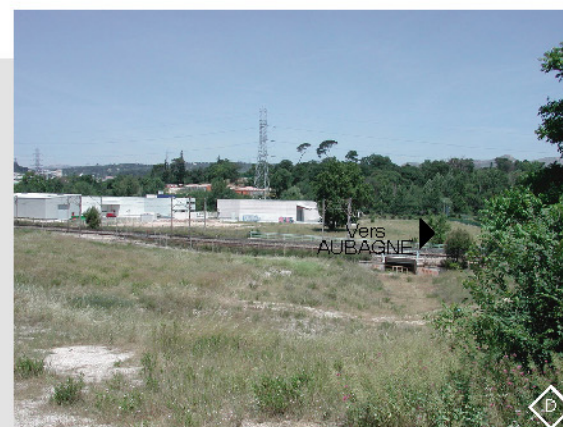
■ Vue côté voie 2 du PRA situé au Pk 9.932
