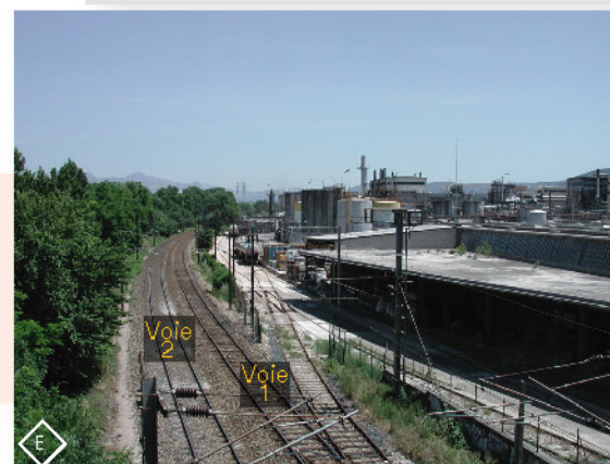
■ Traversée de périmètre SEVESO (usine ATOCHEM) aux alentours du Pk 11.200
