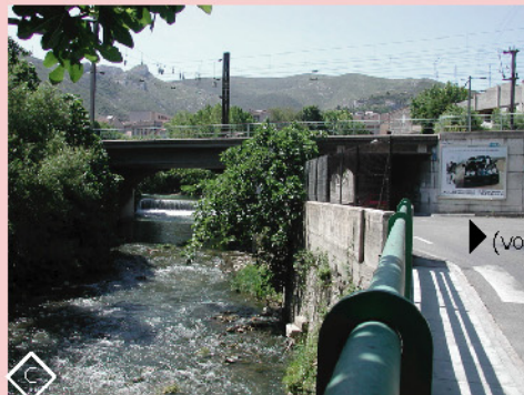
■ Photo prise depuis voirie communale côté voie 2
