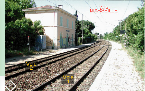
Gare de LA POMME située au Pk 6.237
