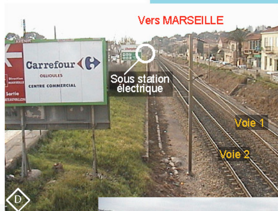
Passerelle Piéton située au Pk 64.090
