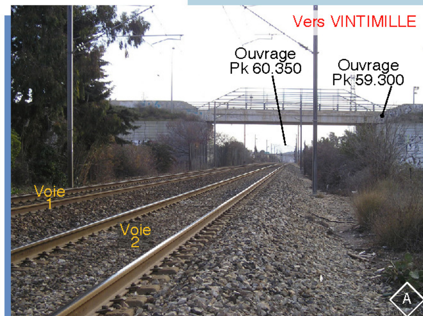
Vue sur l'ouvrage d'art situé au Pk 59.300
