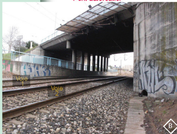
Vues du PRO situé au Pk 70.600
