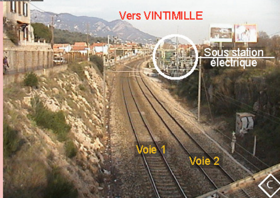
Pk 63.400 Remblai PRO du Pk 63.580
