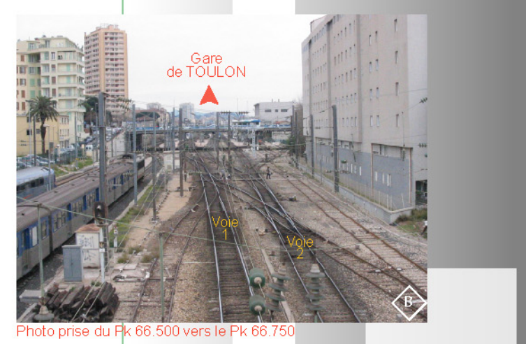
PRO du Pk 66.750 Entrée en Gare (2)
