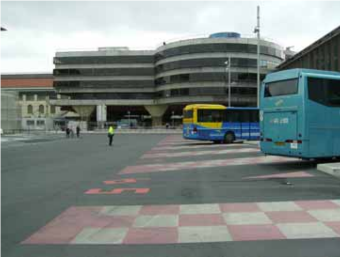
4. Stationnement bus au nord du bâtiment de la Direction Régionale SNCF.
