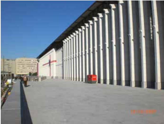
1. Terrasse extérieure du nouveau BV (halle Honnorat)
