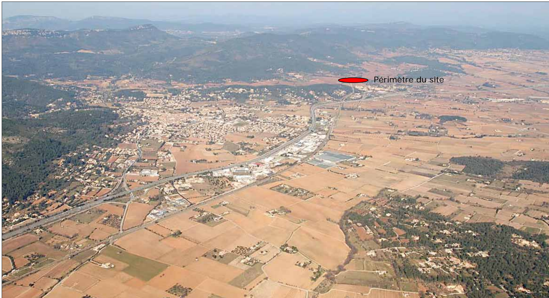
Vue générale autour du site de gare nouvelle de Toulon Nord
