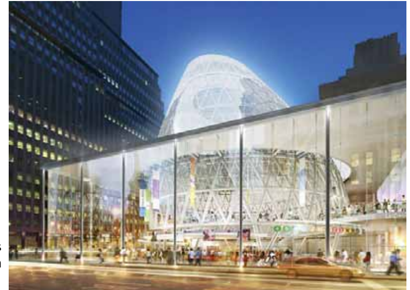
Le dôme d'accès et le pavillon
