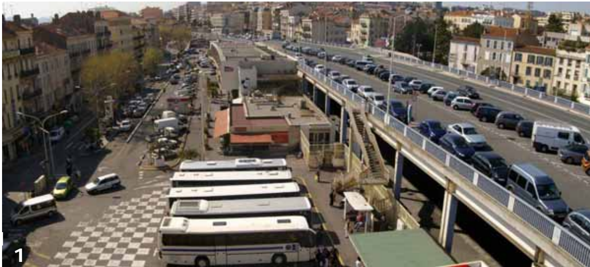
1 Vue de la gare depuis le parking Effia.
