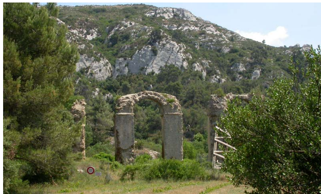
Vues des ruines de l'aqueduc romain à Meyrargues
