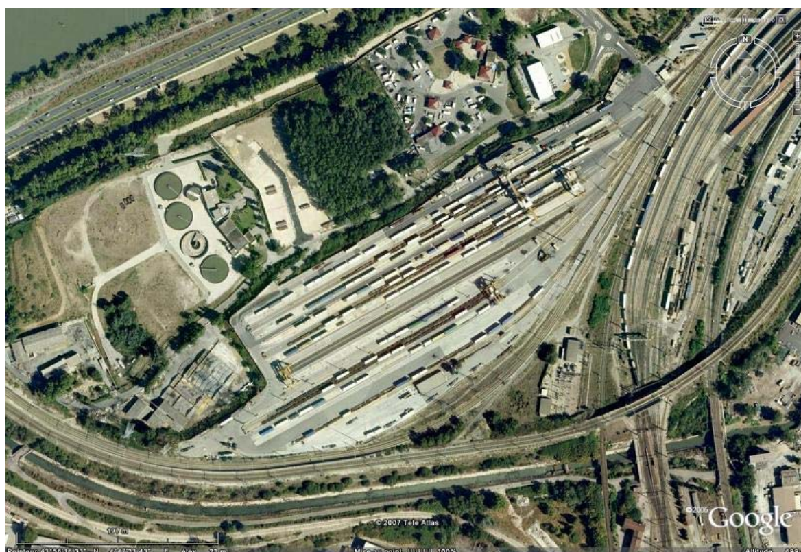
Figure 27 : Photo aérienne du chantier de transport combiné de Courtine
