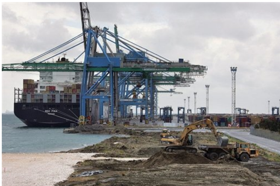
Figure 23 : Le chantier d'extension du port de Marseille "Fos 2XL", le 26 octobre 2007
