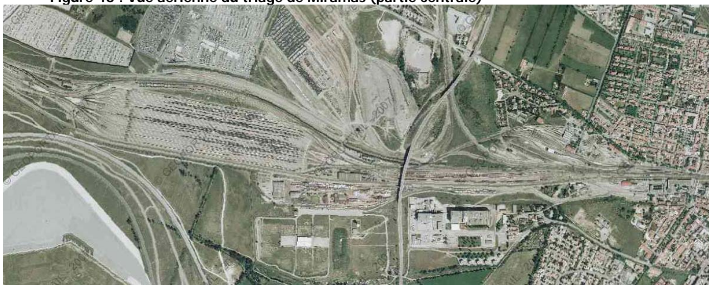
Figure 43 : Vue aérienne du triage de Miramas (partie centrale)
