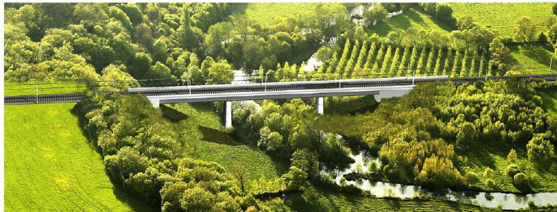
Exemple d'études paysagères et d'esquisses architecturales d'ouvrages d'art sur la LGV SEA (photomontage, maquettes virtuelles, coupe paysagère)
